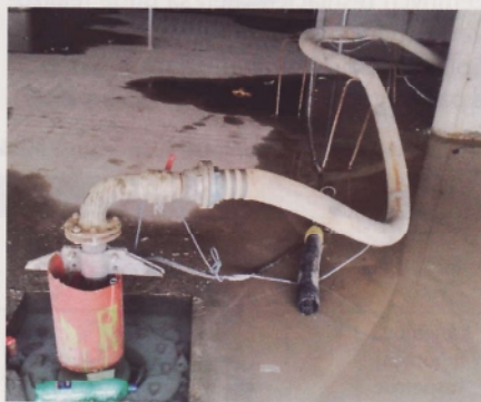
Obr. 10 Vynechaný otvor v základovej doske
