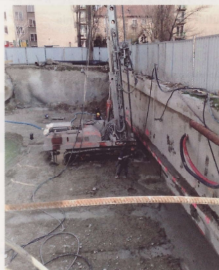
Obr. 2 Prúdová injektáž, CBC Bratislava, 2. etapa
