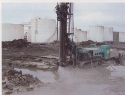
Obr. 1 Vrtné sútyčie so striekajúcim vodným lúčom
