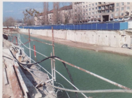
Obr. 9 Stavebná jama, CBC Bratislava, 2. etapa
