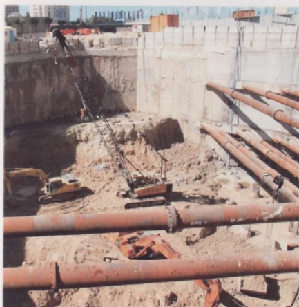
Obr. 8 Stavebná jama pod hladinou podzemnej vody a susediacej rieky (Dubaj)
