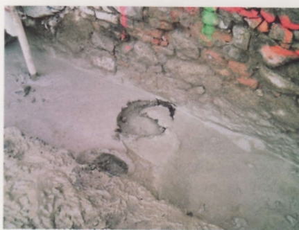
Obr. 7 Ukončenie prúdovej injektáže
