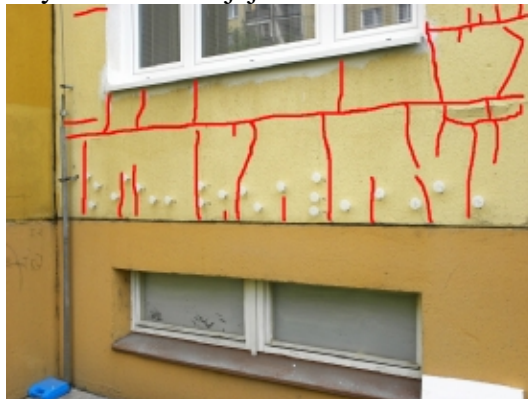
Obr. 7: Situovanie rozperných kotiev v ploche panela
