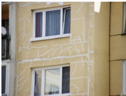
Obr. 1: Obvodový plášť na báze pórobetónu
