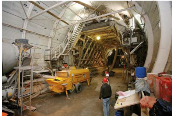
Obr. 3 Betonáž ostení tunelov
