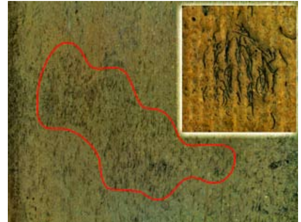
Obr. 10: Zle rozptýlená výstuž odhalená po odfrézovaní povrchu dosky (vpravo hore – detail chumáča ocelových vlákien)
