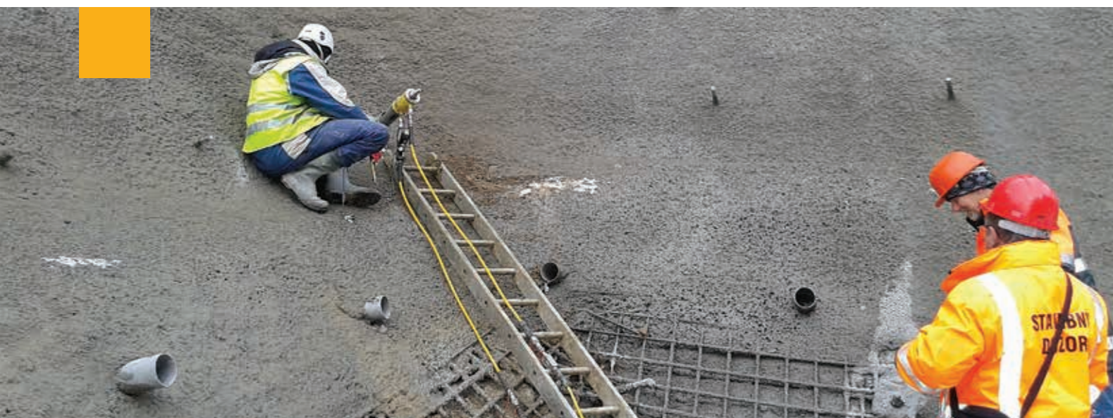
■ Ťahová skúška horninových kotiev – tunel Považský Chlmec / Pull-out test of rock anchors - tunnel Považský Chlmec
