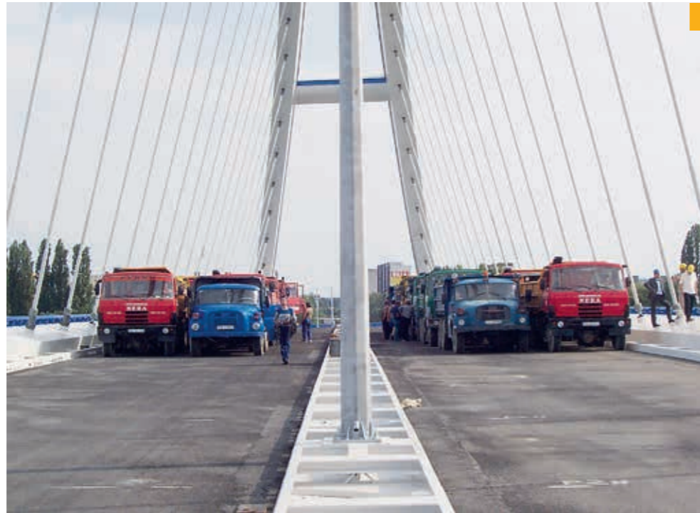
■ Statická zaťažovacia skúška mosta Apollo / Static load test of Apollo bridge
