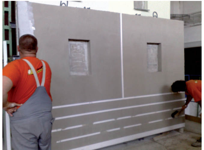
Obr. 16 Čistenie a penetrácia základnej vrstvy
