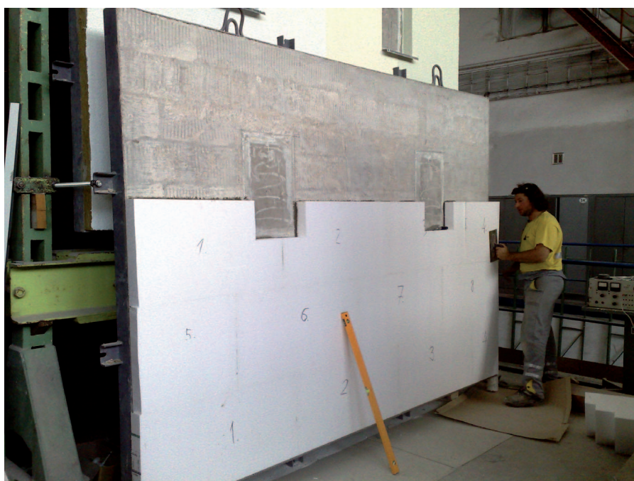
Obr. 14 Lepenie tepelného izolantu EPS
