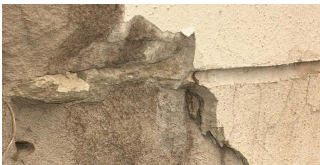
Obrázok 3: Detail škáry medzi prvkami obvodového dielca P 1.15
