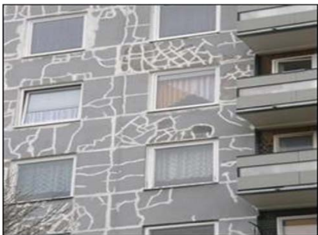
Obrázok 1: Prejavy systémovej poruchy na obvodovom plášt'i hrúbky 240 mm (napr. T 06B NA)
