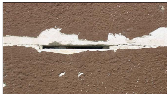
Obrázok 4: Detail škáry medzi prvkami obvodového dielca P 1.15 s vyplavenou výplňou škáry
