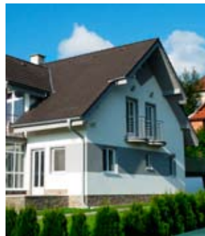
Obr. 9: Príklad vhodného zakomponovania tmavých farieb do fasády – väčšie plochy sú v miestach nevystavených priamemu slnečnému žiareniu (východná fasáda).
