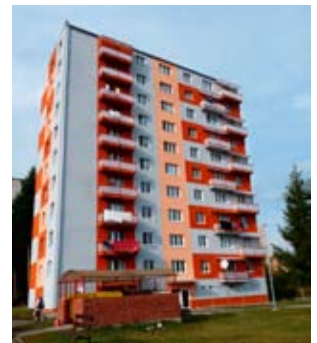
Obr. 10: Príklad menej vhodného zakomponovania tmavých farieb do fasády – väčšie ucelené plochy, navyše líniového tvaru.
