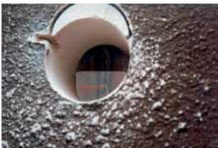
Obr. 8 Jadrový vývrt v mieste kanáliku so spínacou výstužou – kanálik bez zálievky
