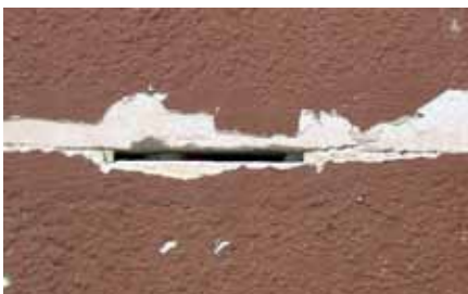
Obr. 9 Ložná škára segmentov obvodového plášťa s drobiacou sa maltou
