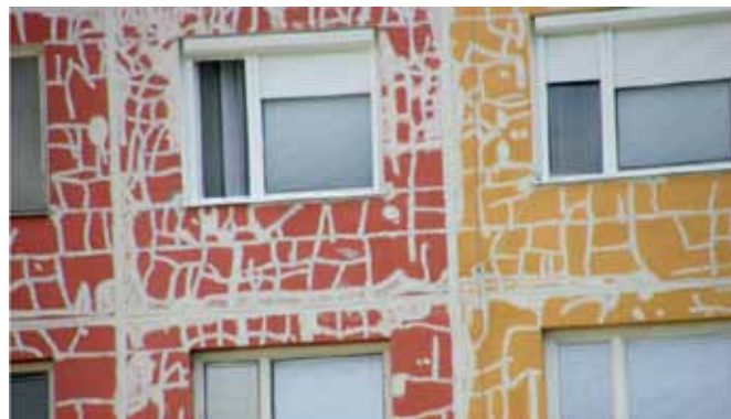
Obr. 4 Vyplnené trhliny obvodového pláštá PS 82 TT, Trnava, Tehelná ulica
