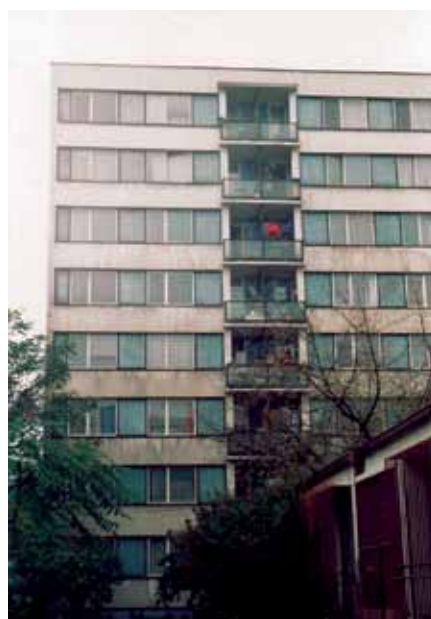
Obr. 5 Bytový dom T 06 B BA, Bratislava
