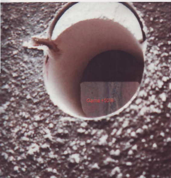
oceleový vývrt v mieste kanáliku so spínacou výstužou – kanálik z zálievky
