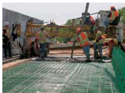
Obr. 14 Liatie betónu s vnútorným ošetrovaním pri budovaní Bartell Road v New Yorku [16]
