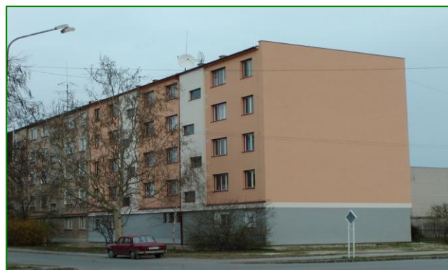
▲ Pohľad na zadnú fasádu bytového domu po zateplení View of the rear façade of the dwelling house following the additional insulating
