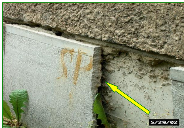
▲ Odpadnutá a oddelená povrchová úprava sokla Fallen and separated finish of the plinth
