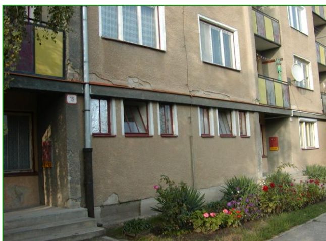
▲ Pohľad na čelnú fasádu – vstupy do domu – pôvodný stav View of the front façade – entrances of the house – original condition.
