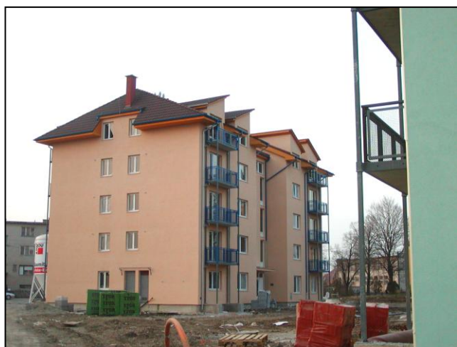
Celkový pohľad na hotové lodžie Overall view of completed loggias
