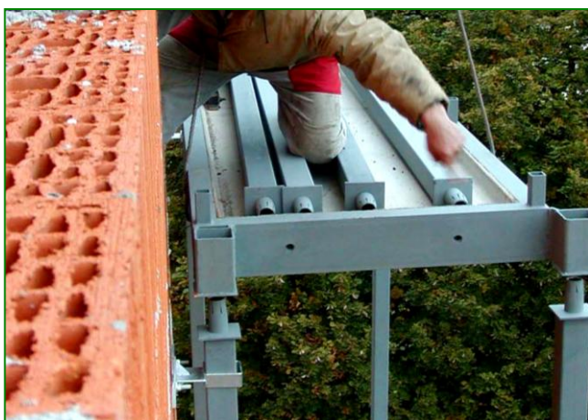
Montáž stropnej dosky na stĺpiky Assembly of ceiling board on columns
