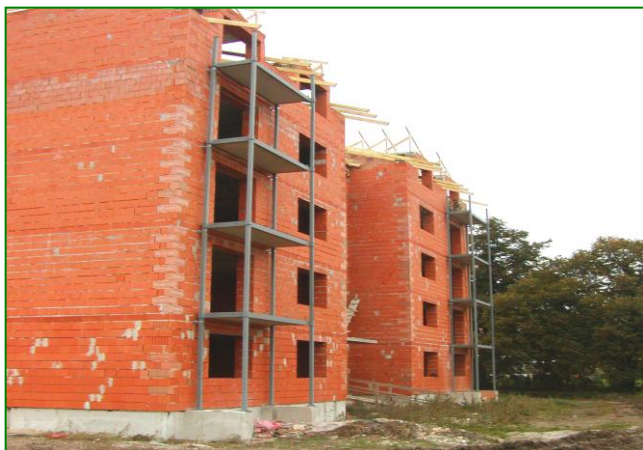
Pohľad na bytový dom počas montáže lodžií View of the apartment building during the assembly of loggias
