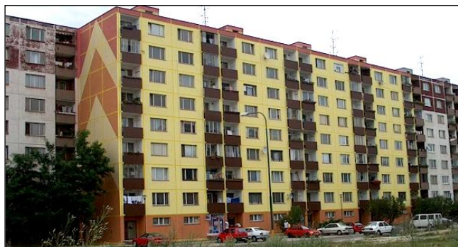
▲ Celkový pohľad na bytový dom P 1.14; Bratislava– Petržalka, Gercenova ul. č.15, 17 – vstupné priečelie s lodžiami General view on the dwelling house P 1.14 - structural system; Bratislava-Petržalka, Gercenova Str. No 15,17. Entrance facade with loggias
