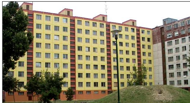
▲ Pohľad na zadné priečelie bytového domu P 1.14; Bratislava– Petržalka, Gercenova ul. č.15, 17 General view on the back facade of dwelling house P 1.14 - structural system; Bratislava-Petržalka, Gercenova Str. No 15,17.
