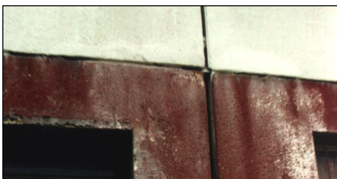
Pohľad na obvodový plášť v pôvodnom stave so škárami vyplnenými tmelom The view on the overall wall with overlaying joints by silicone strips
