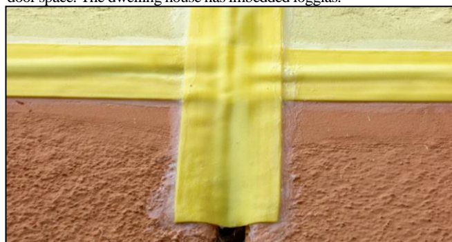
Pohľad na obvodový plášť so škárami prekrytými silikónovými páskami The view on the overall wall in original shape with binding joints
