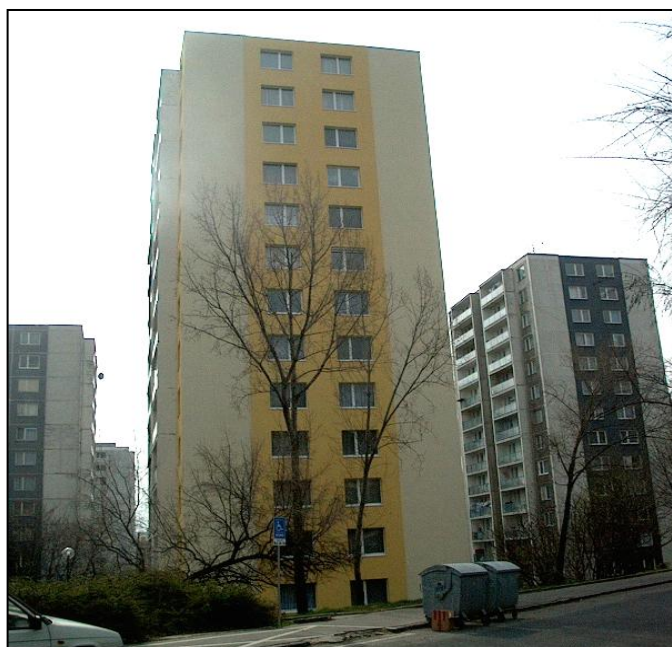
Celkový pohľad na štítovú stenu bytového domu ZT Kuklovska 5 po skončení obnovy General view on the gable wall of the dwelling house ZT – structural system, Kuklovska Str. No 5 after the upgrading
