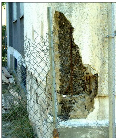
Pohľad na bočnú plochu obkladového panelu po samovoľnom odpadnutí oddelenej hmoty keramzitbetónu View on side parts of facing panel after individual fall of "keramzit-concrete" mass
