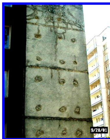
Pohľad na pôvodný stav časti severozápadného štítu View on the north-west gable wall in original shape
