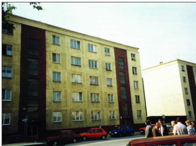
▲ Pôvodný stav bytového domu Original Condition of the Dwelling House
