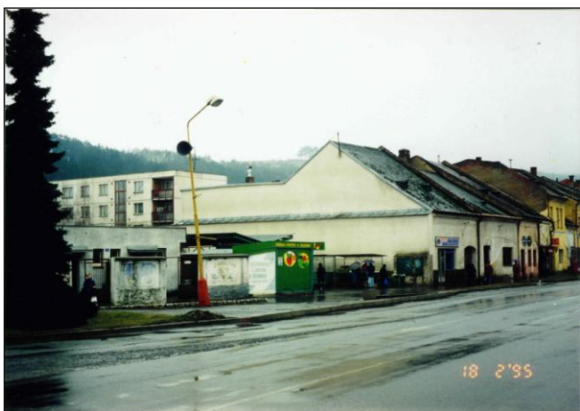
▲ Starý a nový vzhľad bytového domu The original and new look of the refurbished dwelling house
