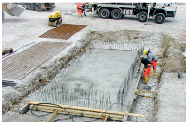
Obrázok 5. 8. 1 Praktická demonstrácia aplikácie betónu so zmesovým cementom druhu CEM V/A (S-V) 32,5 R. Abbildung 5. 8. 1 Praktische Anwendung von Beton mit der Kompositzementsorte CEM V/A (S-V) 32,5 R.
