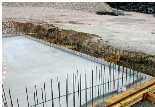
Obrázok 5. 8. 1 Praktická demonstrácia aplikácie betónu so zmesovým cementom druhu CEM V/A (S-V) 32,5 R. Abbildung 5. 8. 1 Praktische Anwendung von Beton mit der Kompositzementsorte CEM V/A (S-V) 32,5 R.
