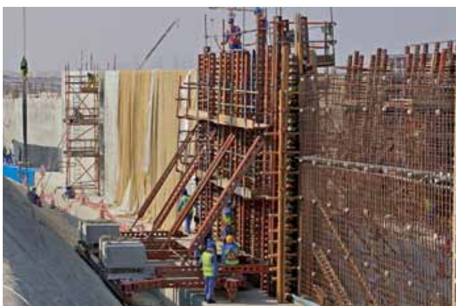
Obr. 12 Veľkoplošné stenové debnenie
