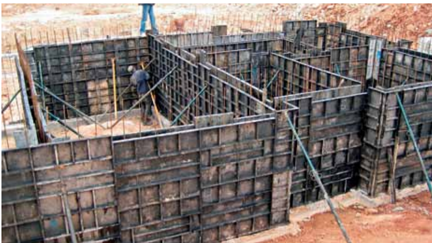
Obr. 18 Debnenie stien spodnej stavby systémovým debnením
