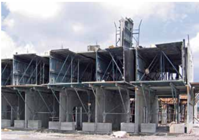
Obr. 10 Tunnelové debnenie
