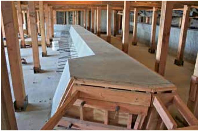
Obr. 4 Tradičné tesárske debnenie
