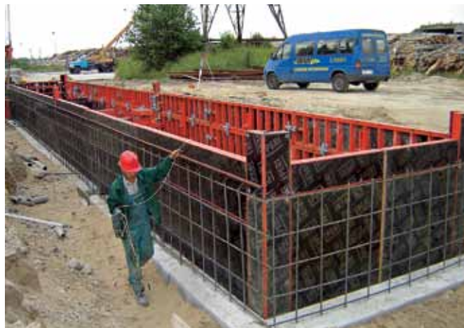
Obr. 11 Maloplošné stenové debnenie
