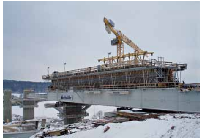
Obr. 15 Pojazdné debnenie
