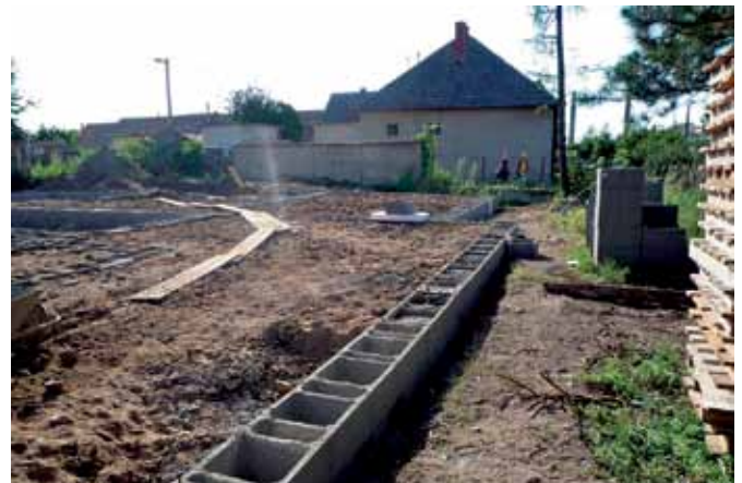
Obr. 17 Základové pásy zhotovené z betónových debniacich tvaroviek
