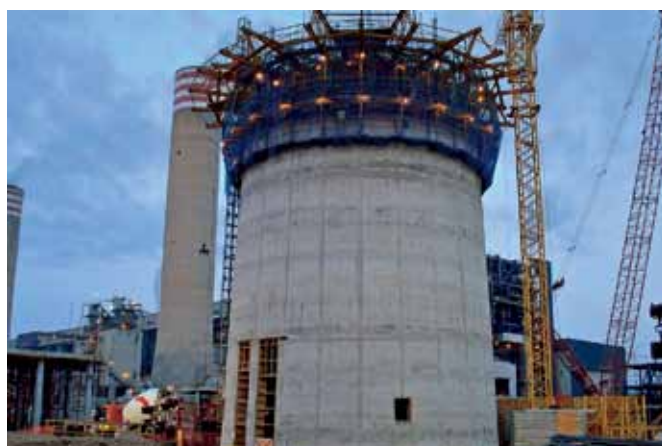
Obr. 13 Posuvné debnenie
