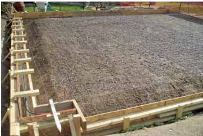
Obr. 16 Obojstranné tesárske debnenie základových pásov
