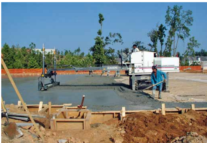
Obr. 6 Betonáž pomocou takzvaného laser screed-u
