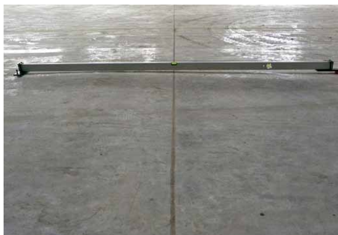
Obr. 9 Nedodržanie miestnej rovinnosti podlahy
