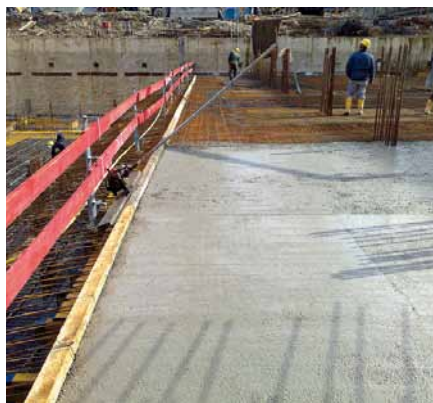
Obr. 1 Betonáž nosných konštrukcií polyfunkčnej stavby v Bratislave
