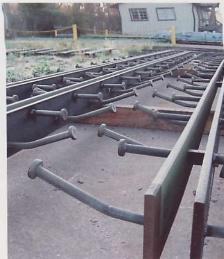
Obr. 11: Výstužné prvky pracovných škár proti drveniu
