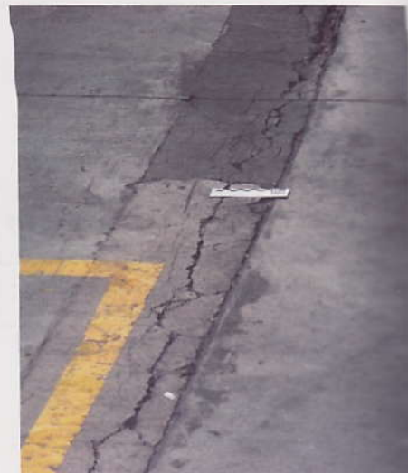
Obr. 13: Odlomený ozub v pracovnej škáre
