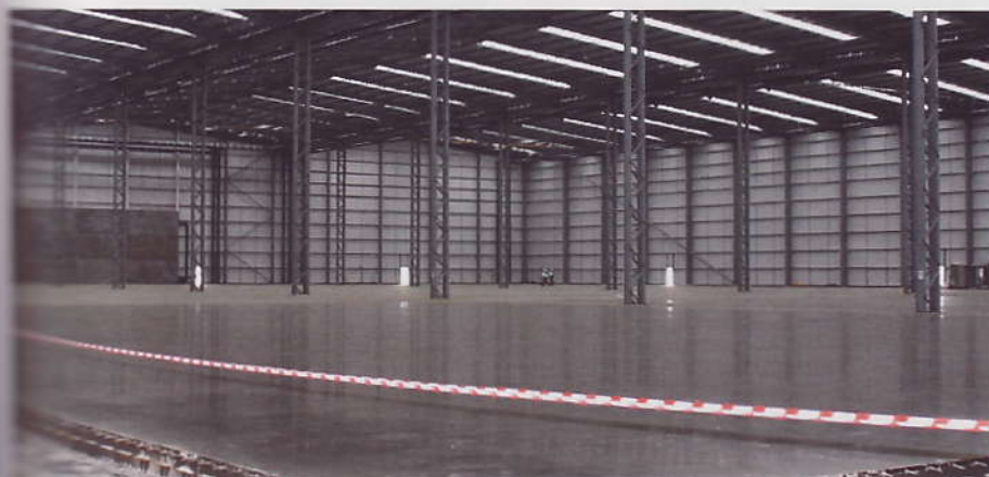
Obr. 16: Správne pripravená polotuhá pracovná škára [7]
