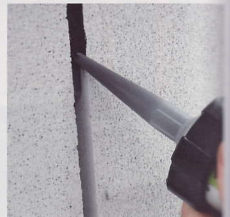
Obr. 2: Dilatačná škára v zvislej konštrukcii
