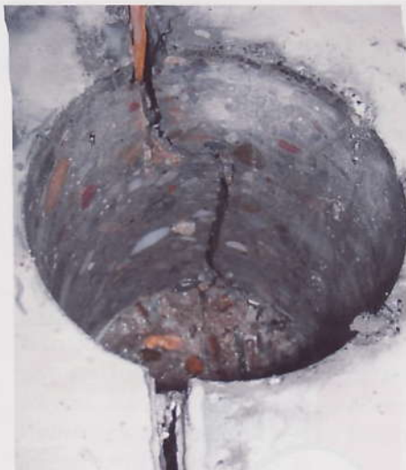
Obr. 12: Tvarovanie pracovnej škáry na ozub bez náležitej úpravy
